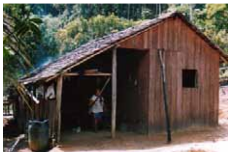
Figura 2: Integração de materiais, técnicas construtivas e o entorno, Casa de morador assentado.
